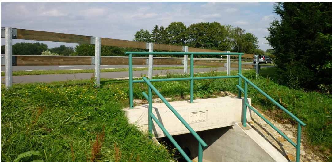
Der Grenzbach: Am „Roten Bach“ quert die neue Straße: Mettingen-Westerkappeln
